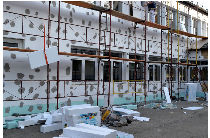
Állványok között az iskola épülete
