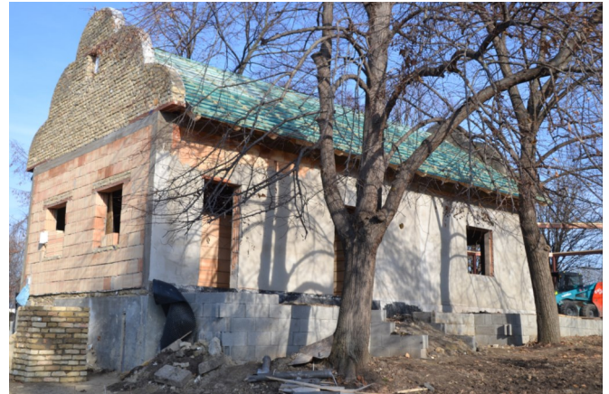
A ravatalozó épülete és környéke, teljes felújításon ment keresztül
