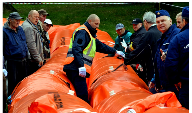
A lajosi tűzoltók feladata a mobilgát felállítása volt
