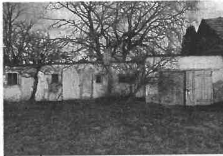
14. Toldalék rész homlokzat
