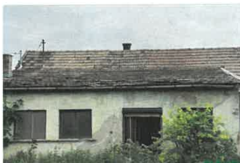
'Hullámos' tetőszerkezet
